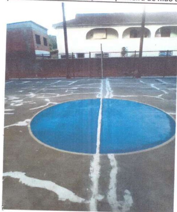
Aplicação da primeira de mão de tinta Latex sobre o piso da quadra
