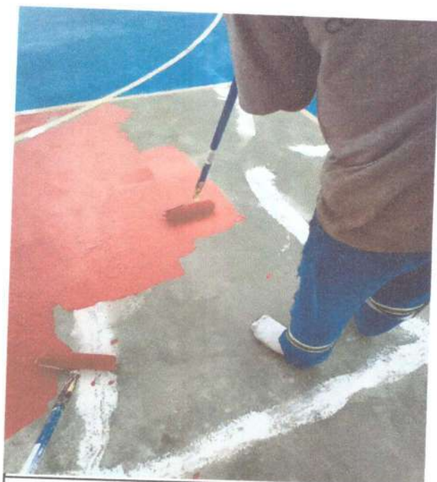
Aplicação da terceira de mão da tinta latex sobre o piso da quadra
