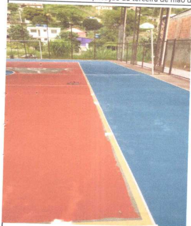
Aplicação da terceira de mão da tinta latex sobre o piso da quadra
