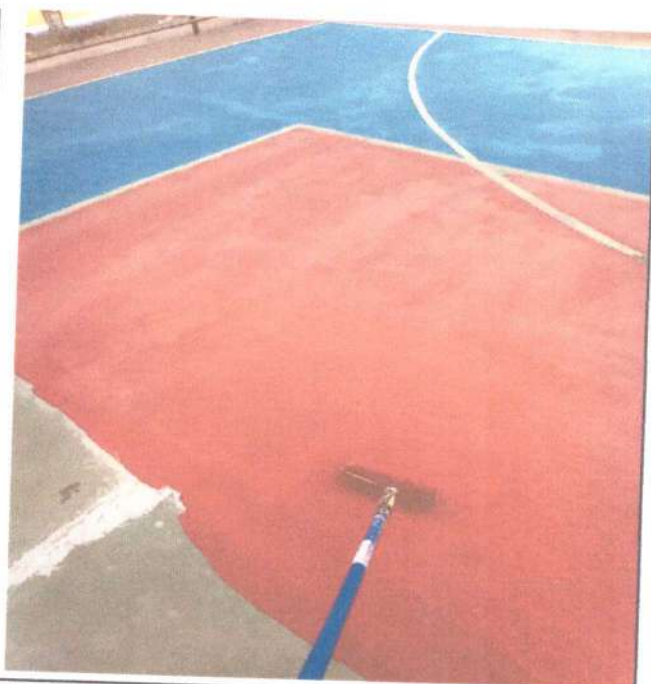
Aplicação da terceira de mão da tinta latex sobre o piso da quadra
