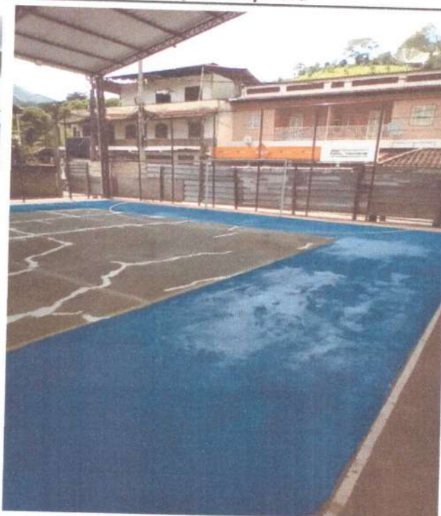
Aplicação da primeira de mão de tinta Latex sobre o piso da quadra
