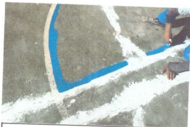
Aplicação da primeira de mão de tinta Latex sobre o piso da quadra
