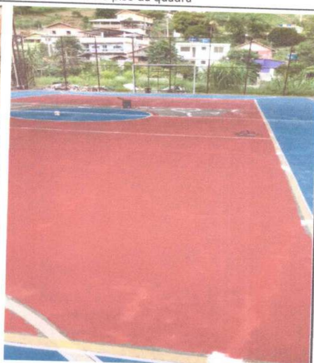
Aplicação da terceira de mão da tinta latex sobre o piso da quadra
